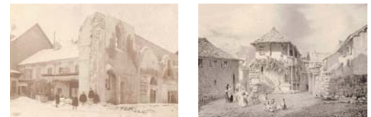
Démolition de l'ancienne église, début XXe siècle.
